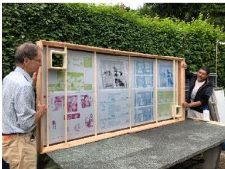
9. Placer l'isolation sur la partie arrière, découper la place d'entrée et sortie d'air / fixer les baguettes (transversales, latérales et de boîtes) en fonction de la jonction entre les panneaux / fermer par les panneaux agrafés sur l'isolation (dans notre tuto des panneaux d'affichage de propylène récupérés)
