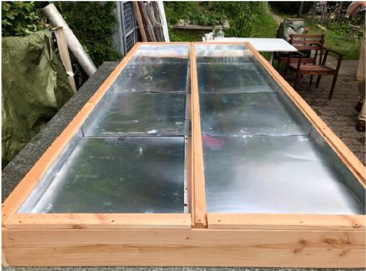
7. Confectionner les boîtes d'entrée/sortie d'air, les placer (couper les tôles en fonction) puis les fixer
